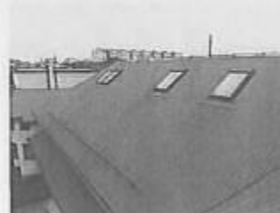
Widok pokrycia dachowego
