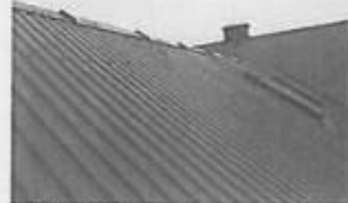
Widok pokrycia dachowego
