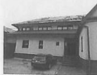
Widok wejścia do budynku: (Wejście od strony ul. Zygmuntowskiej)
