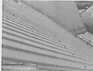
Widok pokrycia dachowego
