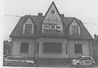
Widok elewacji od strony ul. Radzikowskiego
