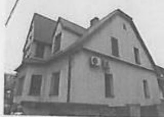
Widok elewacji od strony budynku przy ul. Radzikowskiego 54
