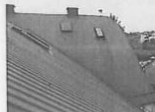
Widok pokrycia dachowego
