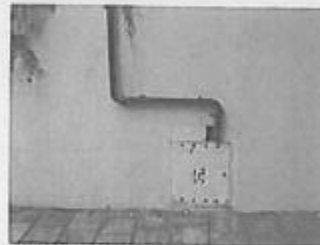
Korekta instalacji doprowadzającej gaz
