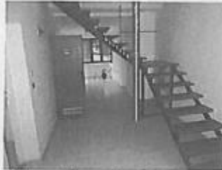
Schody na poddasze z poziomu I piętra
