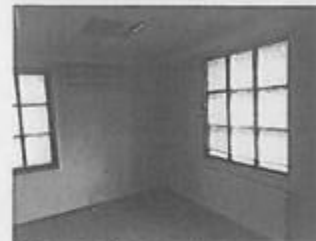
Pomieszczenie biurowe na parterze
