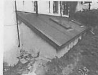
Widok zadaszera nad częścią piwniczną od strony budynku przy ul. Radzikowskiego 54
