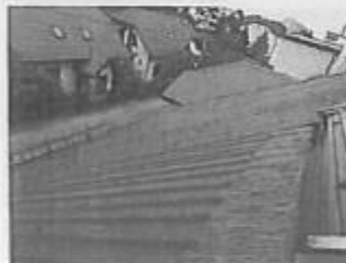
Widok pokrycia dachowego
