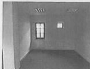
Pomieszczenie biurowe na parterze
